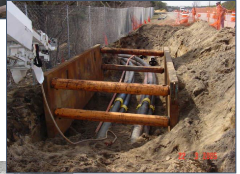
Conduit Installation
